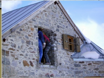
Um einen Ausstieg im Notfall zu erleichtern, wird aus dem Fenster im Männerlager ein Türdurchgang geschaffen
