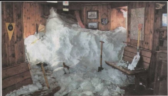
Durch das Erkerfenster hätte sich der Schnee seinen Weg in die Chemnitz Hütte gesucht. Das Fenster rechts wurde durch den Luftdruck nach außen gepreßt. Der hölzerne Steinbock, der am Boden gefunden wurde, stand ursprünglich links an der Wand.
