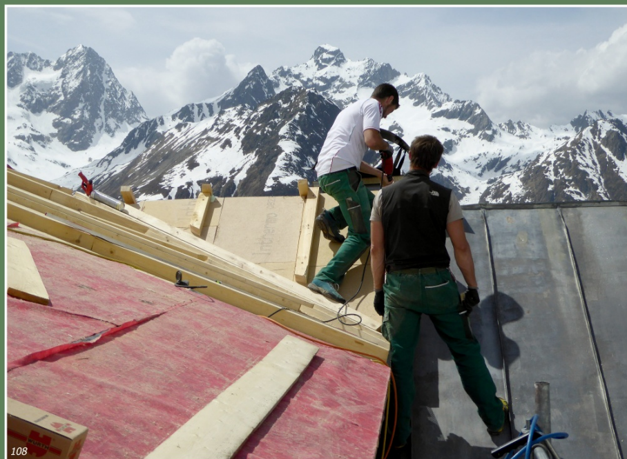
Ein schwieriger Teil: Das Dach des Neubaus muss mit dem des Altbaus verbunden werden. Für gute Handwerker aber kein Problem!
