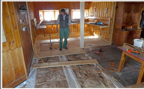
Der Gastraum wirkt nach entfernen der Zwischenwand heller, neue Tragbalken wurden montiert, Dampfsperre und Isolation eingebracht
