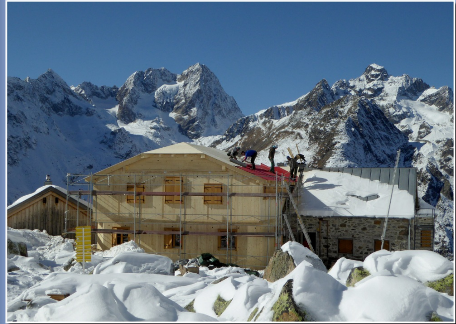
Das Dach wird mit Bitumenbahnen abgedichtet
