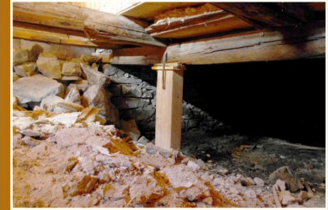
Die Tragbalken für den Gastraumboden werden provisorisch abgestützt
