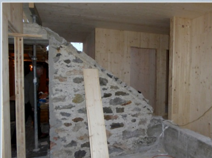
Die alte Giebelwand aus Bruchstein steht noch. Sie wird bald abgerissen.
