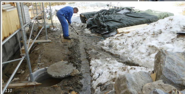
Thomas gräbt eine Rinne, um die Schmelzwasserströme von der Hütte fernzuhalten
