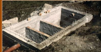
Oben: Der Bau kann beginnen Unten: Die 3-Kammer-Kläranlage im Rohbau
