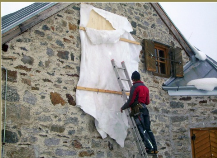
Um einen Ausstieg im Notfall zu erleichtern, wird aus dem Fenster im Männerlager ein Türdurchgang geschaffen
