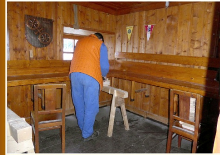
Um den Fußboden im kleinen Gastraum entfernen zu können, muss die Sitzbank hochgesetzt werden. Thomas Velthaus bei der Arbeit.
