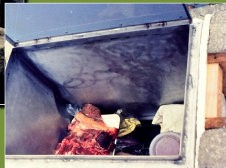
In den 70er Jahren wird eine Kühltruhe beschafft. Sie bestand aus einer doppelwandigen Edelstahlwanne, deren Mantel vom kalten Trinkwasser der Weißmaurachquelle durchflossen wurde. Somit konnte nun das Fleisch und andere Vorräte ständig auf eine Temperatur von ca. 5°C gekühlt werden. Unser rühriges Mitglied Karl Schwarz hatte die Idee und schuf diese fantastische Einrichtung.
