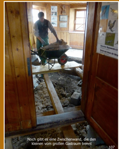
Einige der Tragbalken waren bereits angebrochen, der Boden des Gastraums hatte sich bereits um 8 cm abgesenkt!
