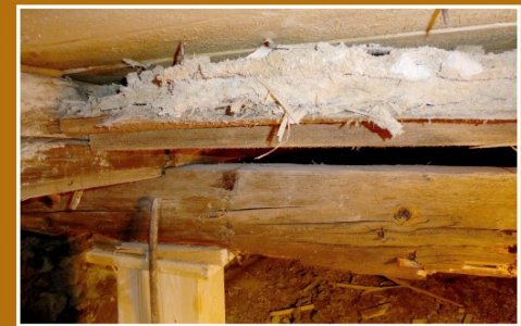
Einige der Tragbalken waren bereits angebrochen, der Boden des Gastraums hatte sich bereits um 8 cm abgesenkt!
