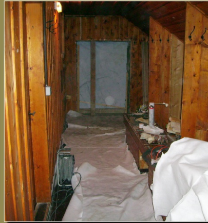
Um einen Ausstieg im Notfall zu erleichtern, wird aus dem Fenster im Männerlager ein Türdurchgang geschaffen
