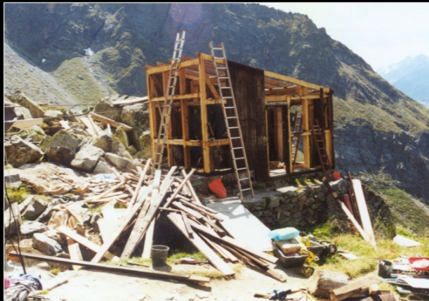
Fundamentarbeiten für den Winterraum
