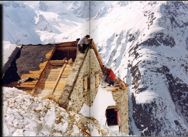
Durch das Erkerfenster hätte sich der Schnee seinen Weg in die Chemnitz Hütte gesucht. Das Fenster rechts wurde durch den Luftdruck nach außen gepreßt. Der hölzerne Steinbock, der am Boden gefunden wurde, stand ursprünglich links an der Wand.
