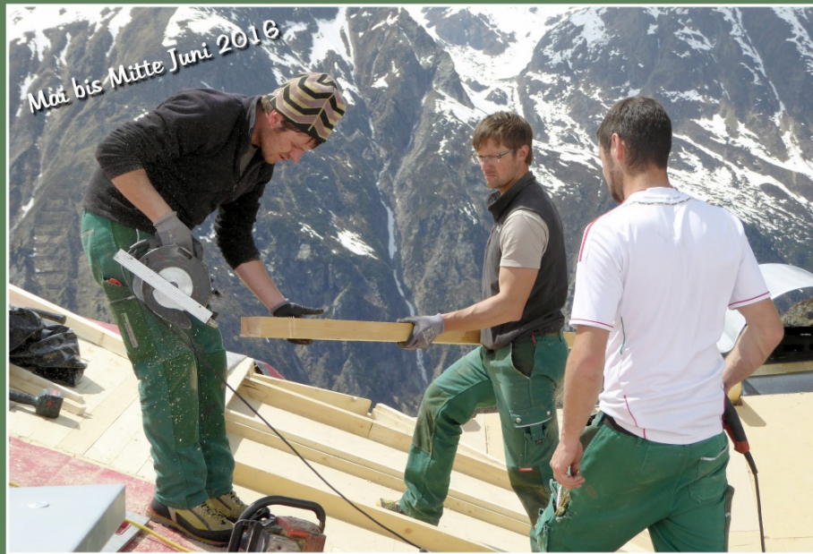
Ein schwieriger Teil: Das Dach des Neubaus muss mit dem des Altbaus verbunden werden. Für gute Handwerker aber kein Problem!
