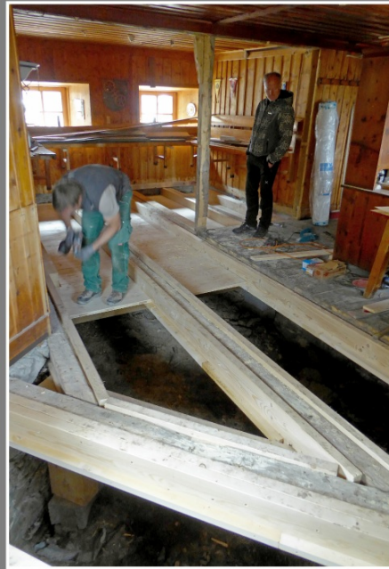
Eine neue Konstruktion trägt nun den Fußboden im Gastraum
