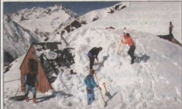
Schaufel für Schaufel mußte die Alpenvereins-hütte im Pitztal wieder freigelegt werden.
