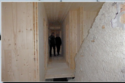
Die alte Giebelwand aus Bruchstein steht noch. Sie wird bald abgerissen.
