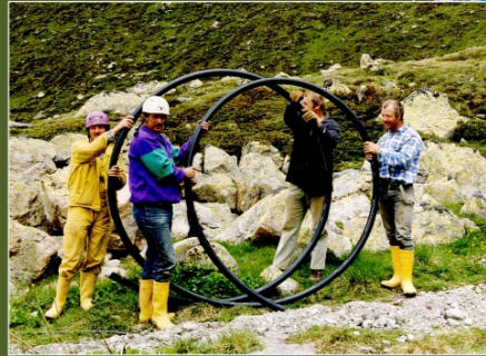
Verlegung der 2"-Kunststoffrohrleitung
