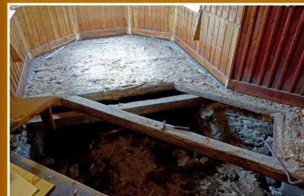
Betonfundamente werden für neue Stützbalken errichtet
