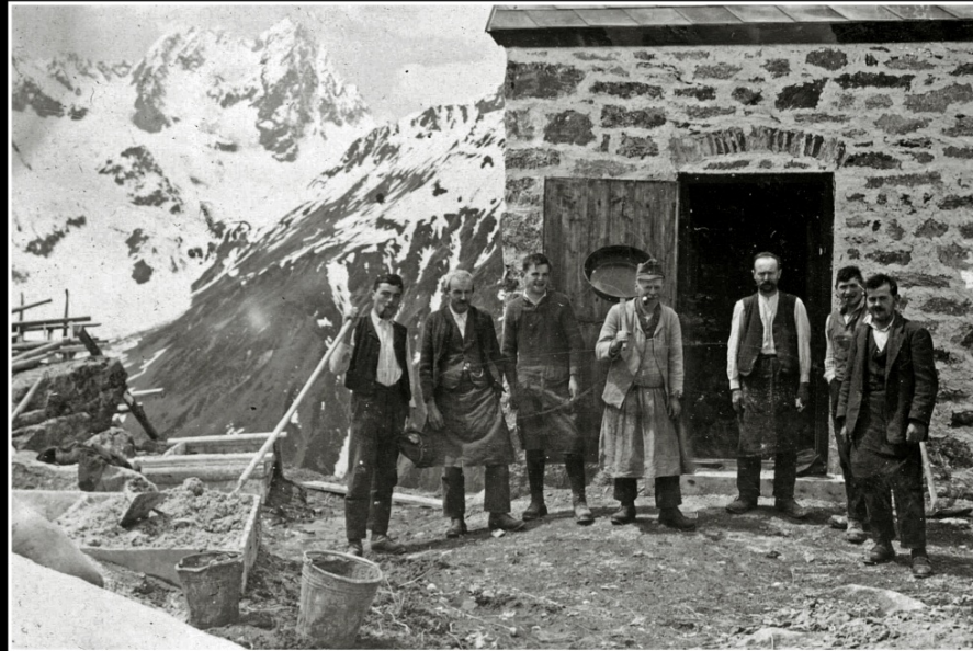
Die Handwerker vor der Einweihung vor der Hütte, das Hüttenschild ist noch nicht montiert
