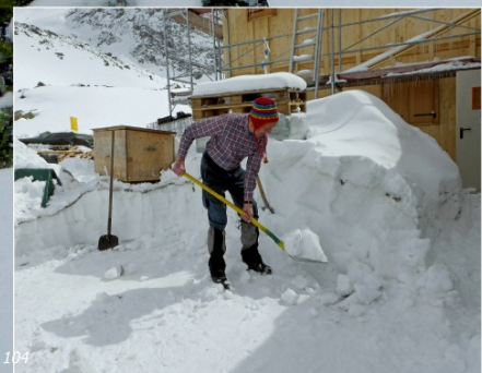
Endloses Schnee schippen, um die tief unter dem Schnee ruhenden Baumaterialien freizubekommen.
