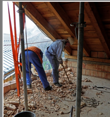
Ein hartes Stück Arbeit: Abriss der Giebelwand im "neuen Lager"
