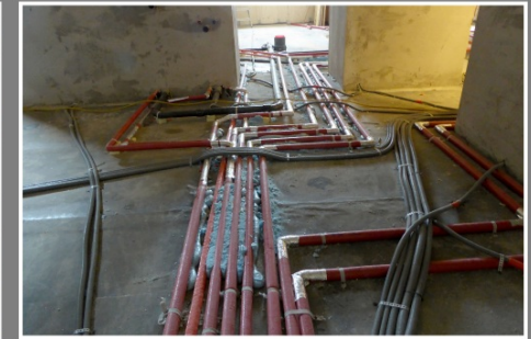
Diese Installationen für Warm- und Kaltwasser, Heizung und Elektrokabel verschwinden bald im Estrich des Bodens.
