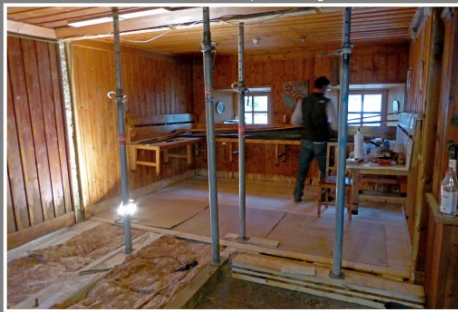
Der Gastraum wirkt nach entfernen der Zwischenwand heller, neue Tragbalken wurden montiert, Dampfsperre und Isolation eingebracht
