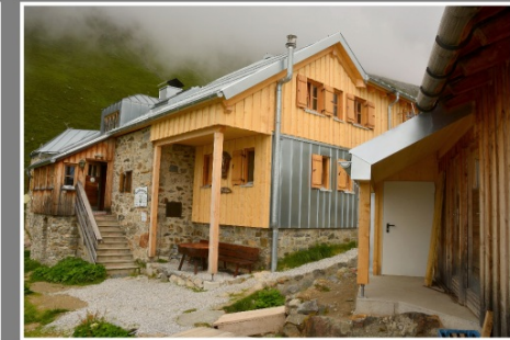
Eingangsbereich und Zugang zum Technikraum, rechts
